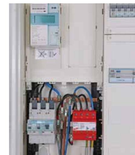
Použití DEHNshield se svorkami STAK 25
