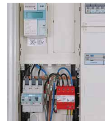
Použití DEHNshield se svorkami STAK 25
