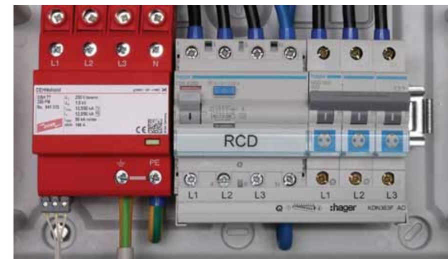
Použití DEHNshield se svorkami STAK 25
